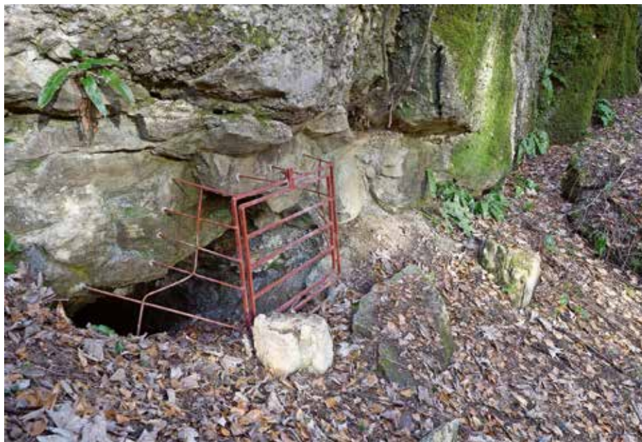
Eigenkonstruktion: Das vor dem Stolleneingang montierte Gittertor schliesst Störenfriede aus, lässt Fledermäuse und andere Stollenbewohner hingegen passieren.
