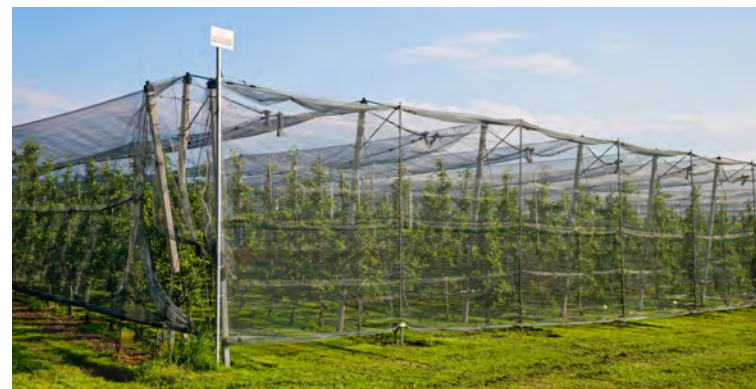
Abbildung 13: Das vollständige Abriegeln von Niederstammanlagen mit Hagelnetzen verwehrt dem Braunen Langohr den Zugang zu einem wichtigen Jagdlebensraum (Foto: René Güttinger).
