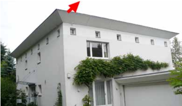
Abbildung 4: Wochenstubenquartier Im Sonnenfeld 10 A, Romanshorn. Der rote Pfeil markiert die Ausflugsöffnung.
